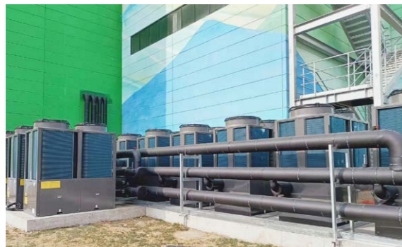
北京2022年冬奥会与冬残奥会主物流中心项目季取暖项目
