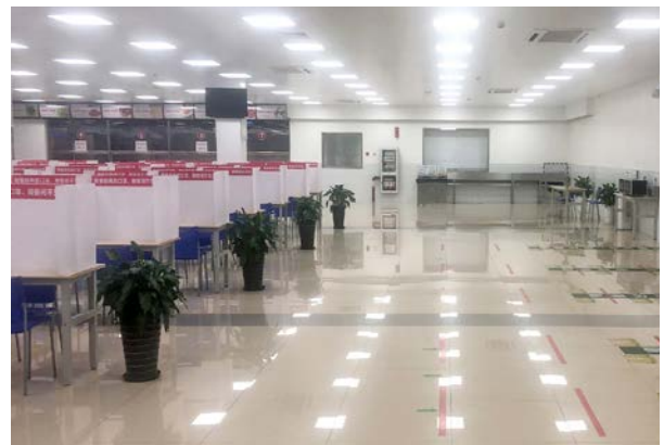
更换LED照明灯具
